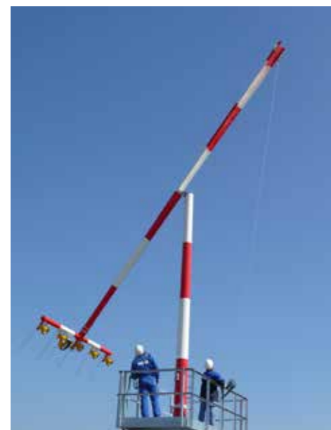
Mast in Hybridbauweise – Airport Zweibrücken
